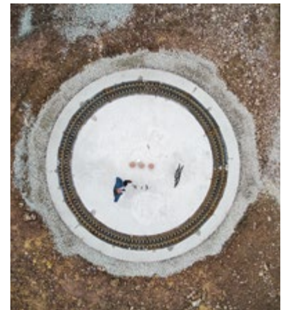
Die Fundamente für die Windräder stehen bereits.
