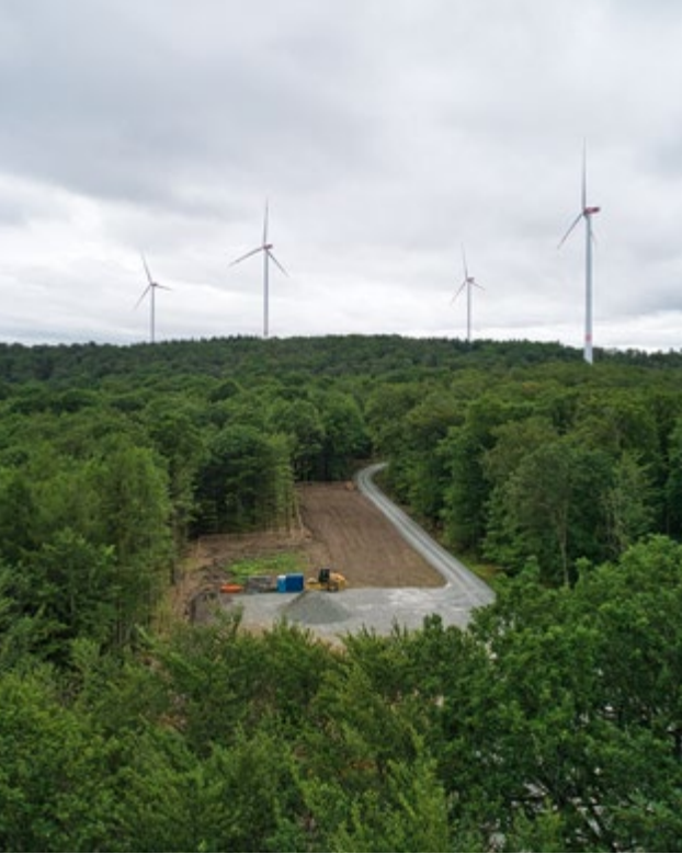
Die Rodungs- und Kabelarbeiten sind abgeschlossen, die Zufahrtswege angelegt.
