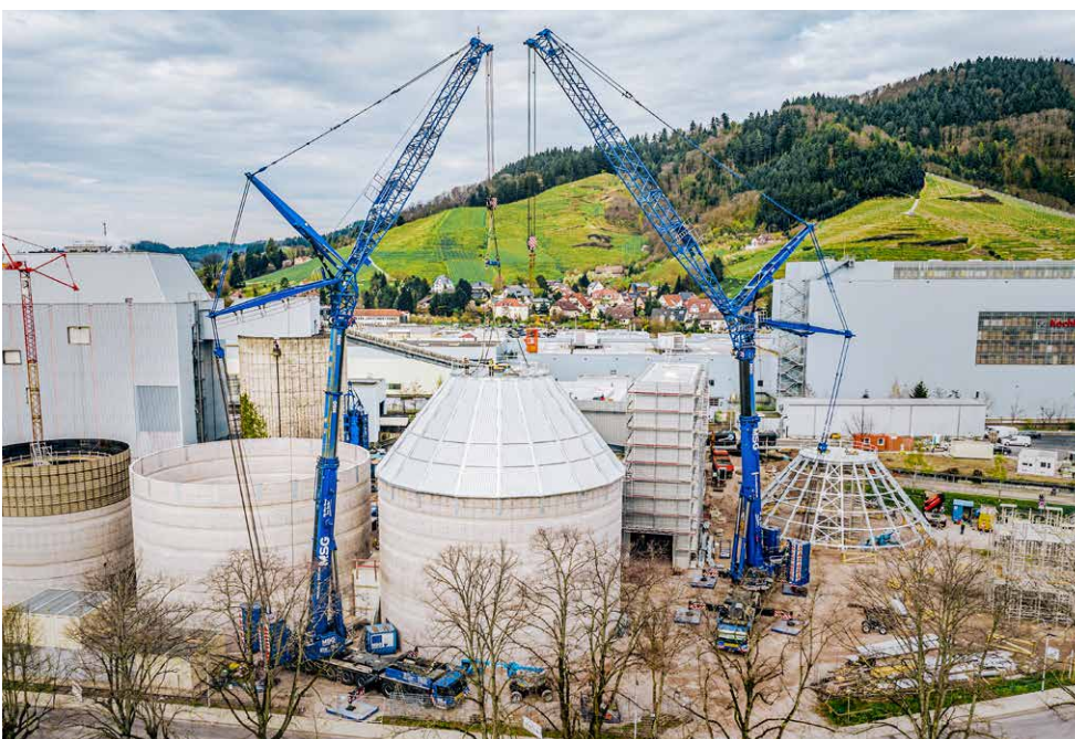
Für die Lagerung der Biomasse wurden vier Silos errichtet.
